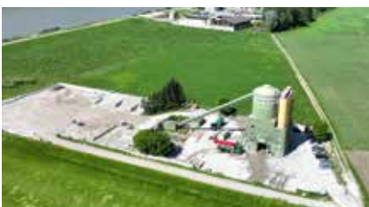
Mauthausen / Rems Beton GmbH, Betonwerk
