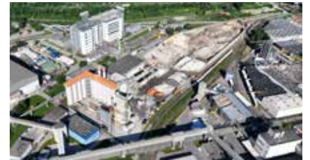
Linz I / Betonwerk, Recyclinganlage
