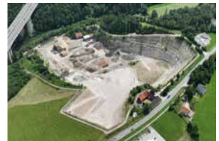
Klaus II / BA-Deponie, Recyclinganlage
