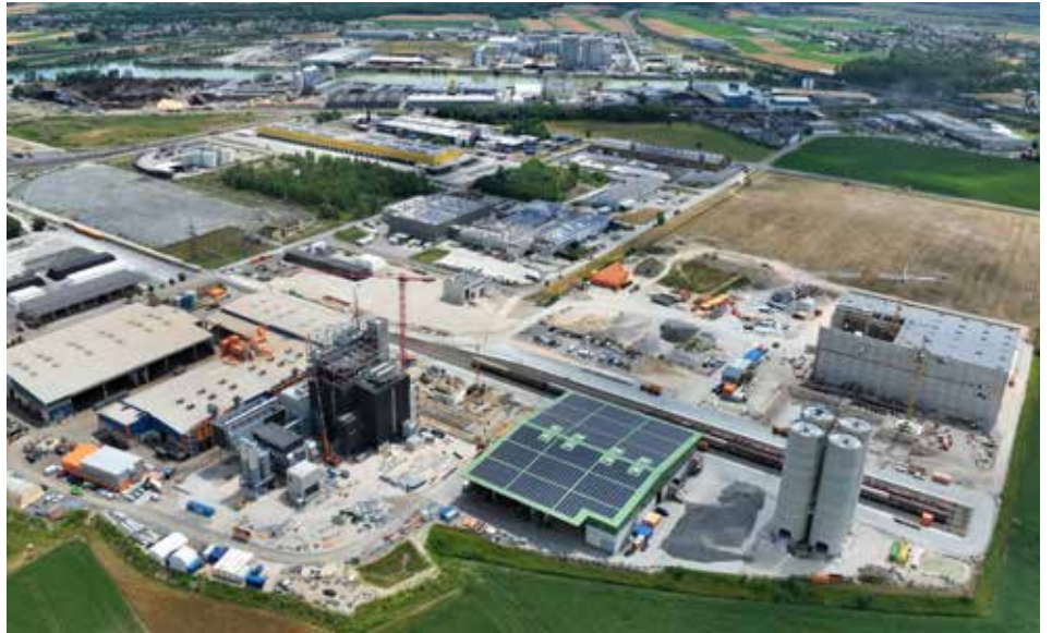
Enns / TBS GmbH, Shredderrückstandaufbereitungsanlage, Hochsiloanlage, Anschlussbahn Recyclinganlage, Thermische Metallgewinnung, Kunststoffsortieranlage
