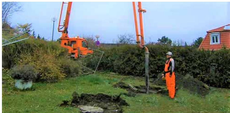
Hohlraumverfüllung Brunn am Gebirge
