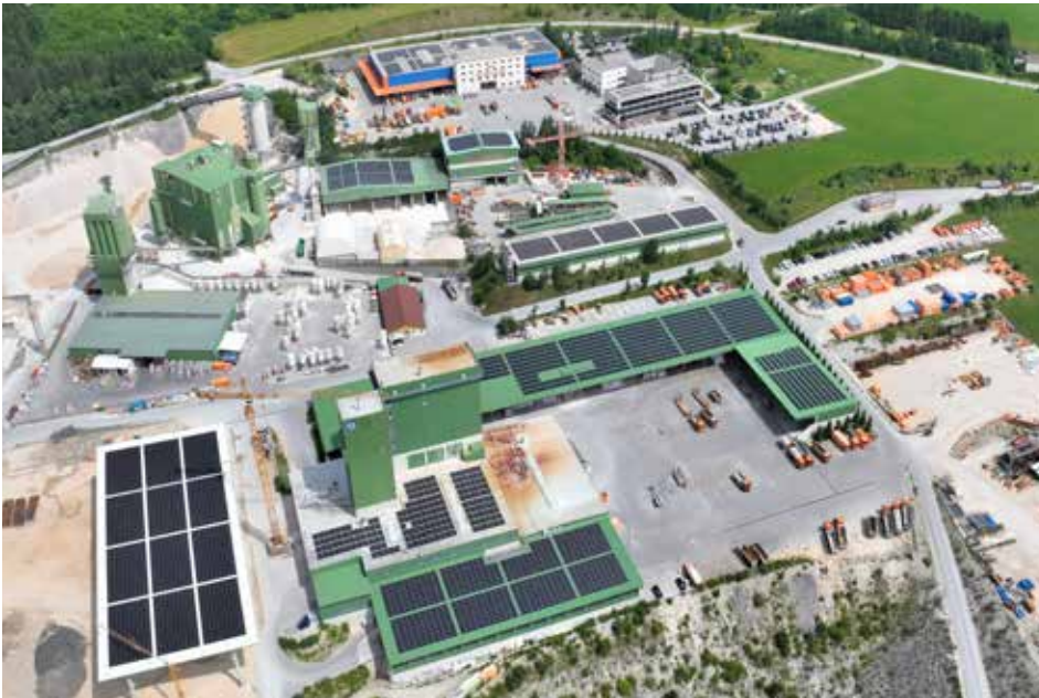
Molln / Firmenzentrale, Mahl-, Misch- u. Granulierwerk, BA-Deponie Gaisberg
