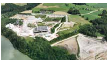
Ternberg / Kies- und Betonwerk, BRM-Deponie, Recyclinganlage
