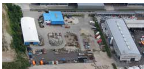
Kematen an der Ybbs / Bachner Brunnen- und Spezialtiefbau GmbH
