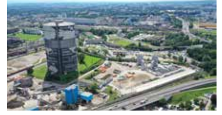
Linz II / Recyclinganlage, Anschlussbahn und Arge Ground Unit / Nasstrennanlagen
