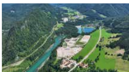
Schlader / Kiesabbau, BRM- u. RS-Deponie
