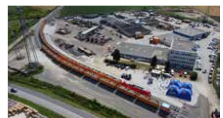
Leobendorf, Spezialtiefbau, Anschlussbahn
